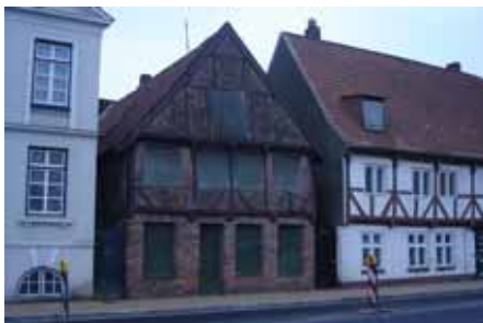
Abb. 68: Leerstand in der Denkerstraße (Altstadt)
